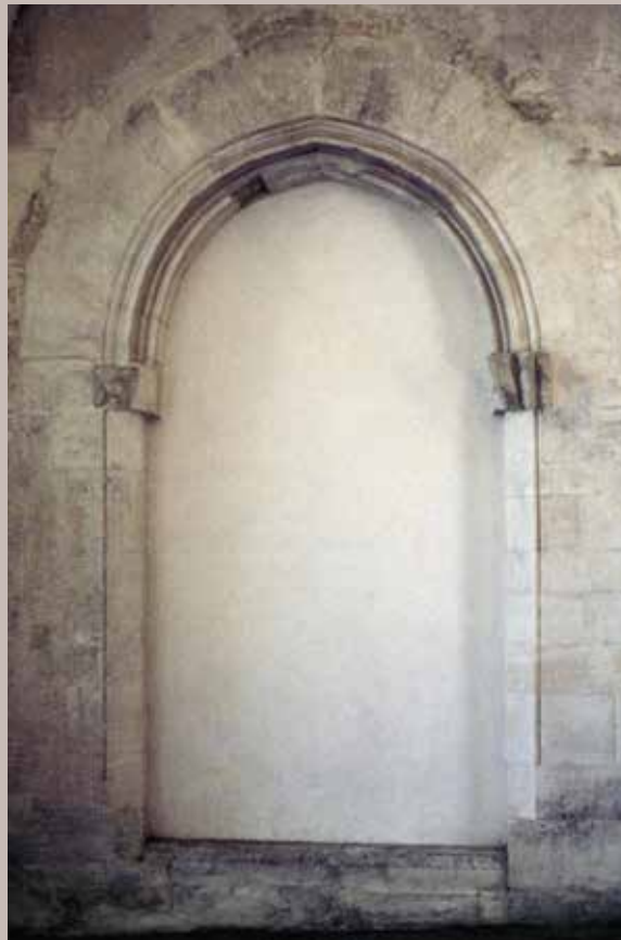
Plaça Major. Arc de Sant Agustí restaurat, 1983.
